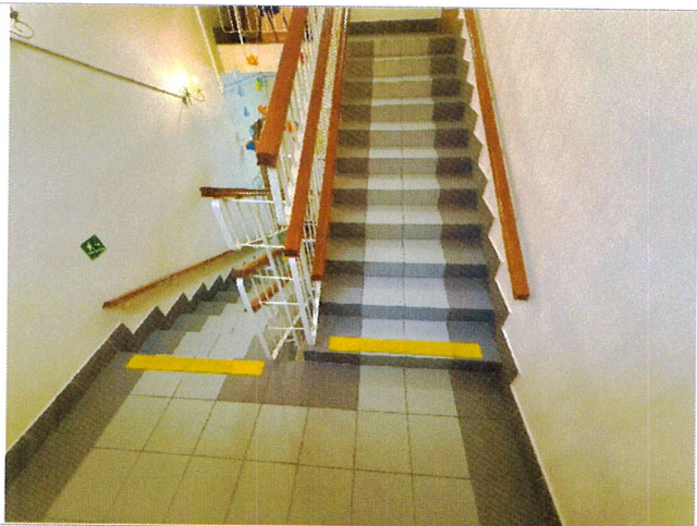
Фото №35– Пути движения внутри здания (лестницы).
