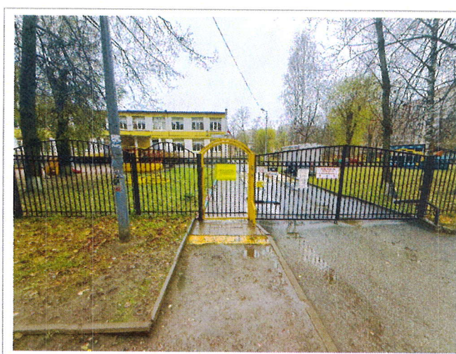
Фото № 2 – Подходы к объекту.
