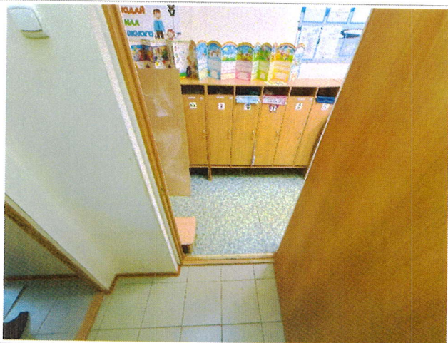
Фото №19 – Внутренняя входная дверь.
