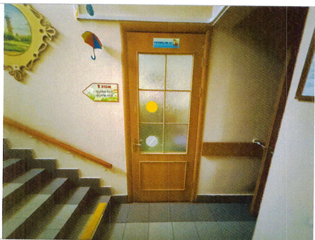
Фото №25– Пути движения внутри здания (двери). Вход в группу.
