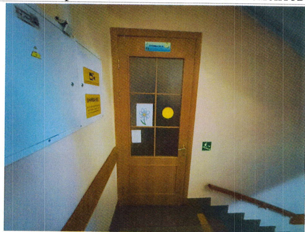
Фото № 26 – Пути движения внутри здания (двери). Вход в группу.
