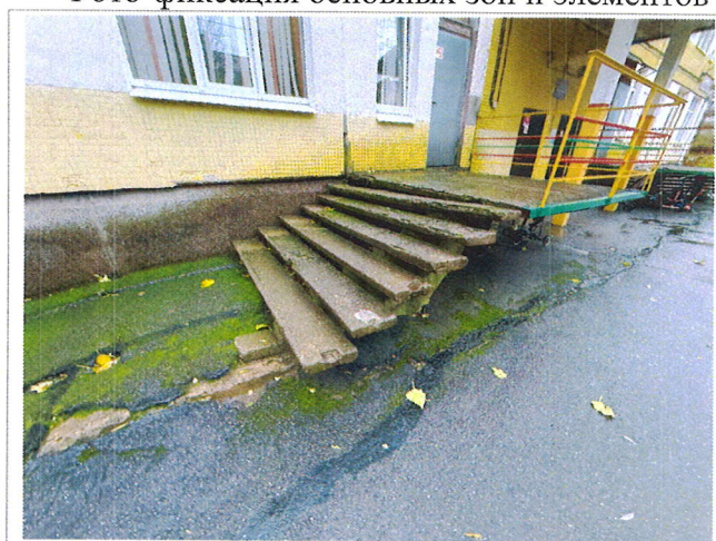
Фото № 14 – Наружная лестница.
