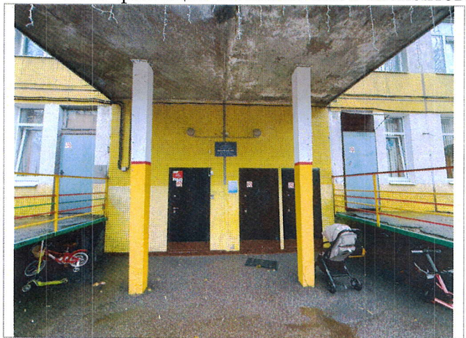
Фото № 8 – Главный вход. Входная площадка.
