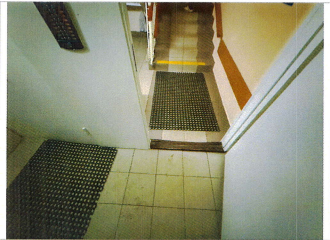
Фото № 11 – Внутренняя входная дверь.
