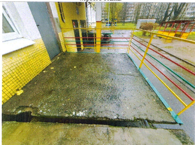
Фото № 15 – Входная площадка.
